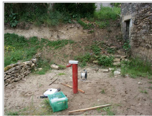
Installation d'une sonde CPI
